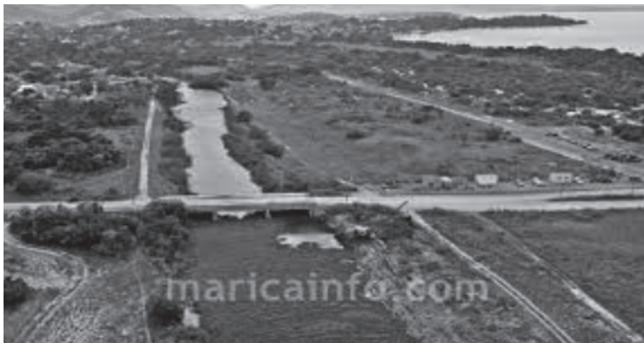
Foto 2 e 3: Rede de esgotamento sanitário terá 130 km
