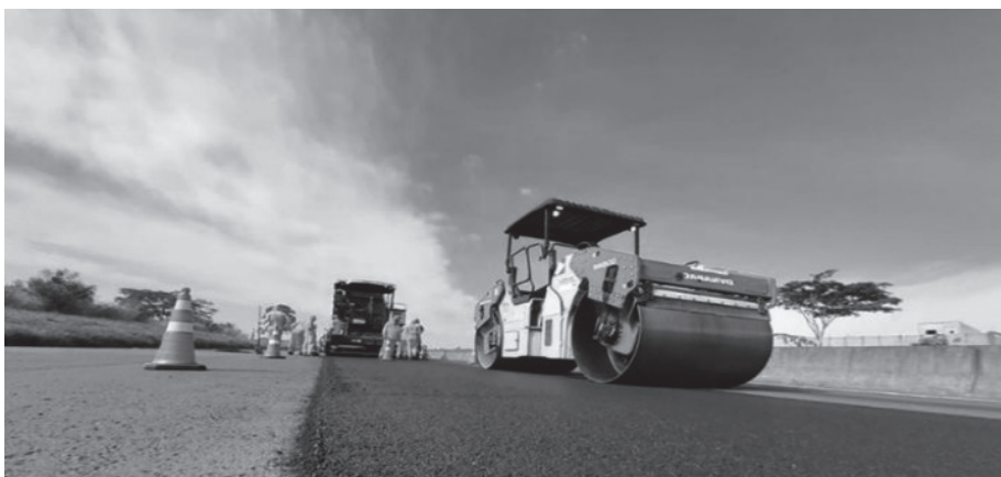
Imagem 3- Trabalhadores pavimentando as ruas de São Paulo.
