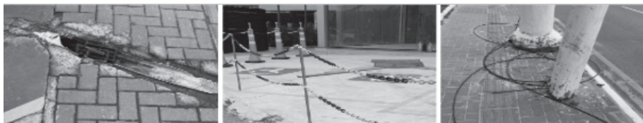
Figura 4 - Buraco com esgoto exposto na calçada; Vagas reservadas com acesso bloqueado por correntes; Postes e fios a pouca distância e invadindo a rota acessível sinalizada pelo piso tátil
