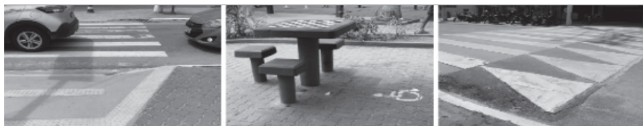
Figura 3 - Faixa de Pedestres corretamente sinalizada; Espaço reservado para cadeirante em mesa de jogo na praça sinalizado; Travessia de pedestres elevada e nivelada com a calçada
